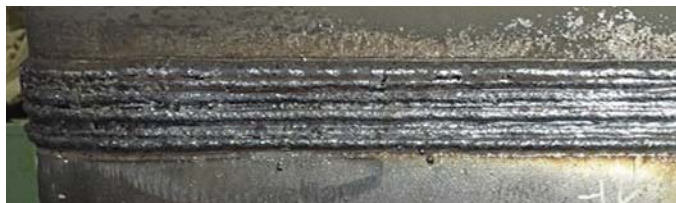
コラム溶接直線部
