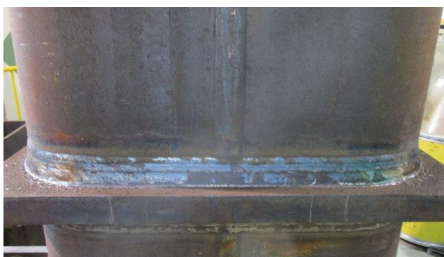
SX-55 の溶接外観
