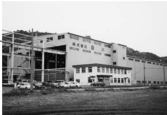
工場外観の一部
