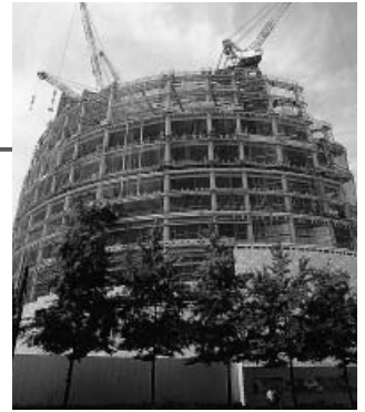
鉄骨工事時のNHK大阪放送会館。写真に見 える柱材(丸コラム)に同社製品が採用された
