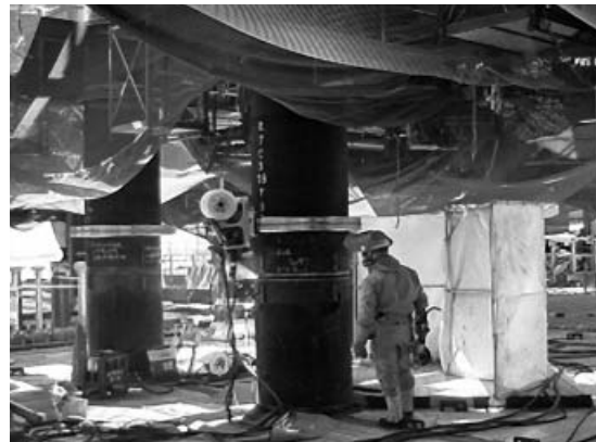
鋼管柱の横向き溶接
