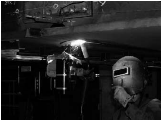
橋梁の下フランジ上向き溶接
