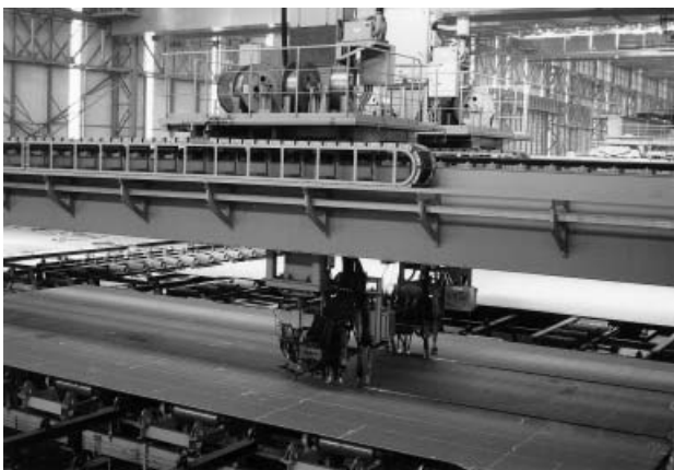
写真1 4電極高速片面溶接法(NH-HISAW法)のパネルラインへの適用例
