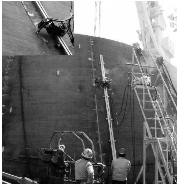
写真6 「Ez-Track」の三次元曲がりブロック立向突合せ自動溶接への適用例
