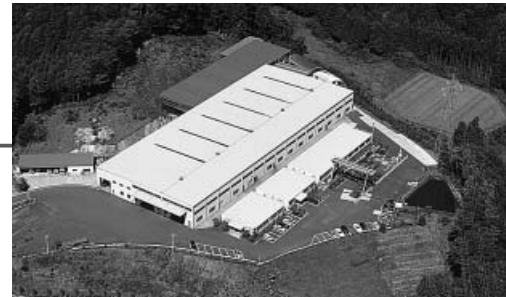
田園地帯の中の高台に建つ本社・工場全景
