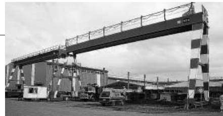
大型クレーンが装備されている屋外ヤード
