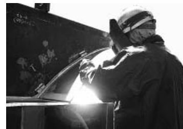
(株)ニツツ殿による溶接施工例
