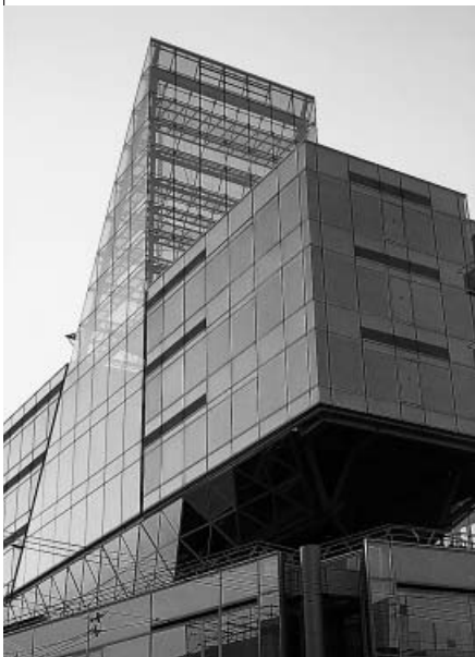
総合力が遺憾なく発揮された代表的実績の一つ「サンシップとやま」。帆船をあしらったユニークな形状であり、総ガラス張り、4点支柱による構造物の支持など、多くの技術課題をクリアし高度な技術力が高く評価された
