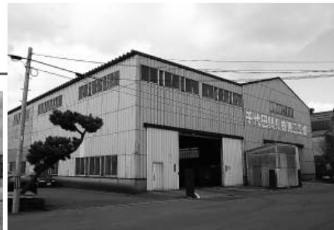
ロボット溶接が導入されている第二工場の外観
