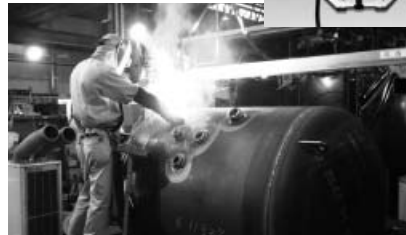
下向き突合せ溶接としてSY-miniが採用されている
