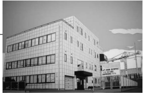
事務棟（左手前）と工場棟（一部）、ジブクレーン
