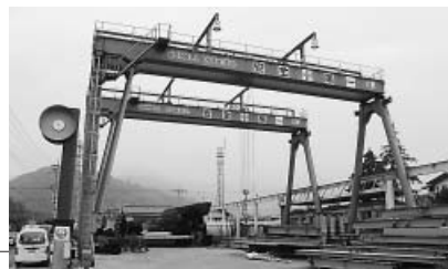
門型10トンクレーン2基が並ぶ鋼材ヤード
