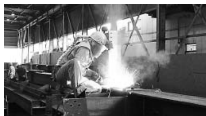
◎YM-26(ワイヤ径1.4ミリ、400キロパック)による溶接状況
