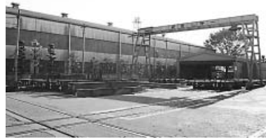
泉沢工場の仮組みヤード
