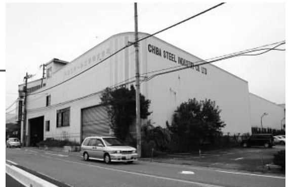
道路側から見た工場棟(一部)
