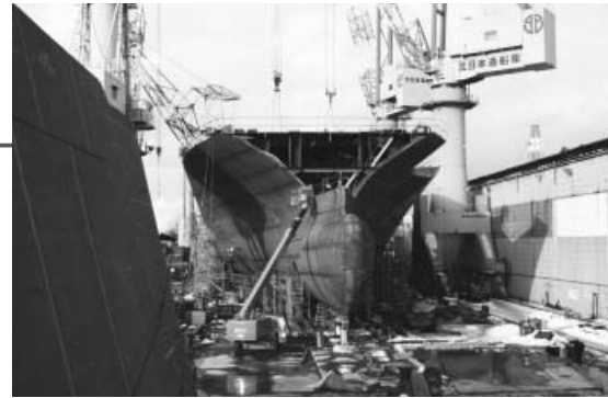
建造中のRO-RO船(11,000DWTクラス)の船首部分
