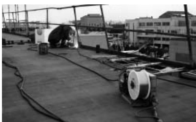
◎SF-1による甲板上での溶接状況
