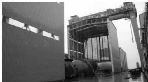
屋外移動式上屋における加工組立状況。 出荷用岸壁に向けてタンクを移動させていく
