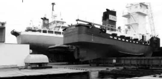
訪問時には3隻の修繕船が並んでおり、修繕作業が進められていた
