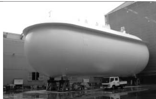
塗装を終えたタンク。直径約10m、長さ約30m。手前のトラックとの比較で大きさが分かる
