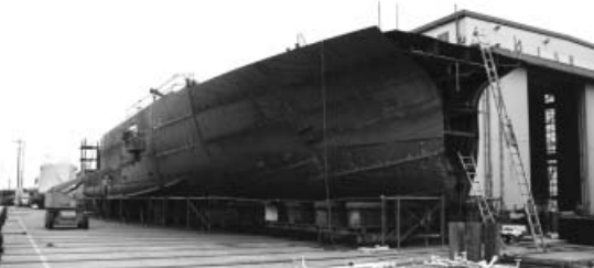
新造船として建造が進められている内航タンカー。全長約80mで999t規模のもの
