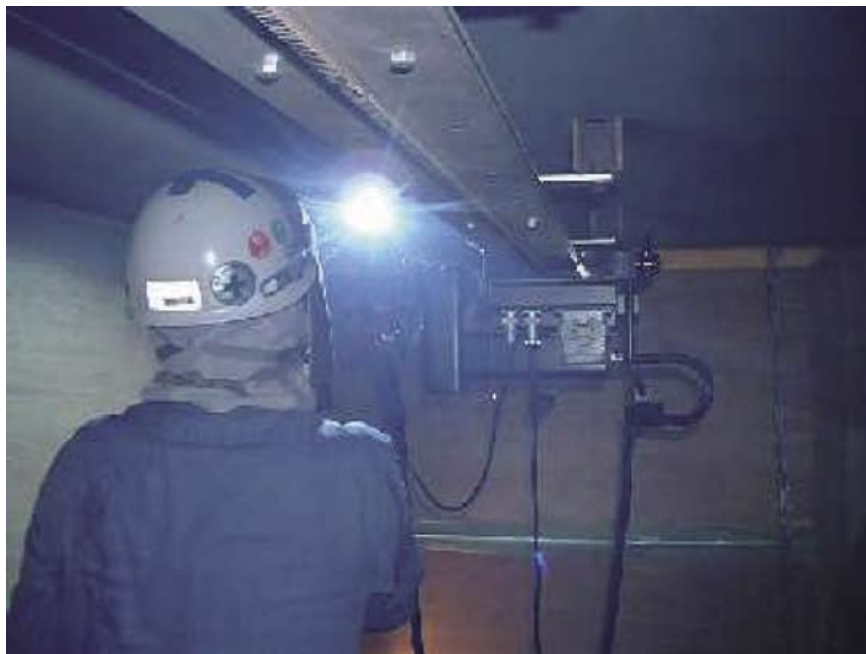
写真-7 上向き溶接適用例 (ワイヤ：◎FC-1A)
