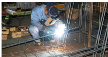
◎NS-03Tによる金網の溶接状況
