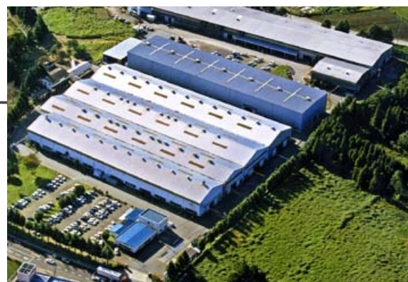
本社・香取工場全景
