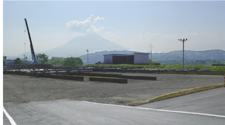
同社のストックヤード。東北地区の鉄骨ファブでは同社のように広いストックヤードを持ち、その有効利用が競争力を高める要素の一つとなっている
