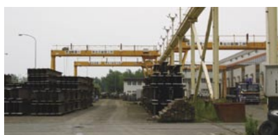
門型クレーンが装備されている屋外ヤード
