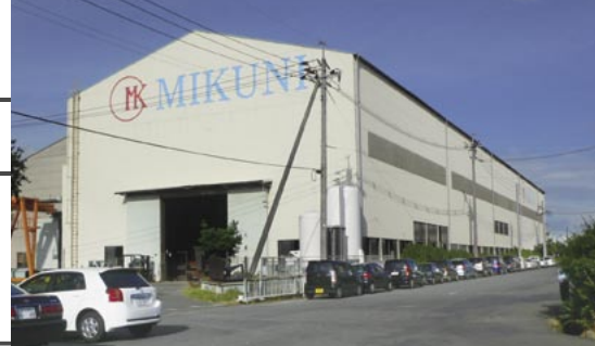
鉄構工場の外観
