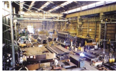
鉄構工場の内部
