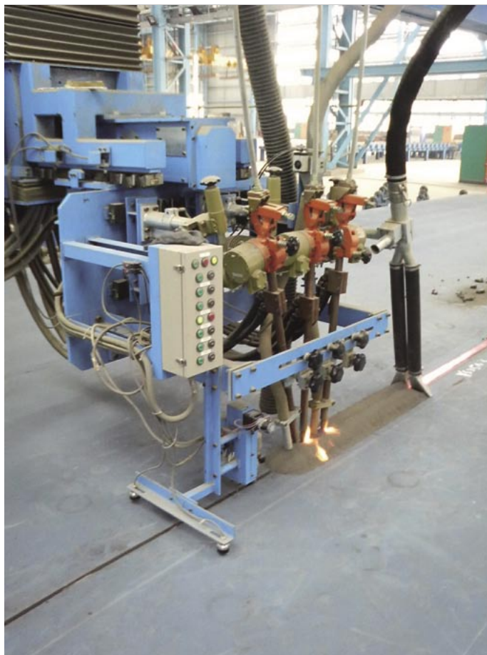
片面溶接状況
