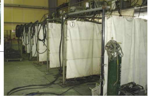
建築現場で溶接作業中の同社のウェルダー
