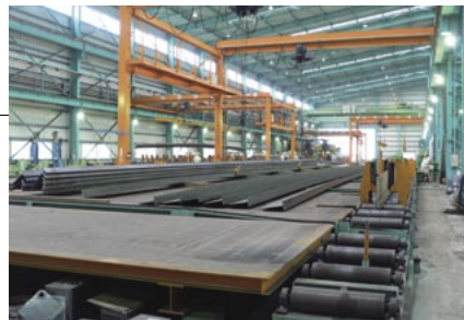
組立棟の内部。左奥に見えるのが HS-MAG 装置 (ツインタンデム×3ライン)
