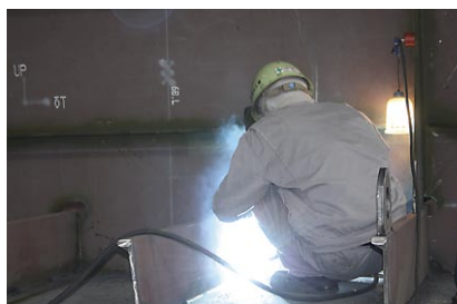
SF-1による溶接作業の例
