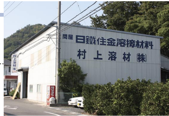
倉庫と一体となった事務所
