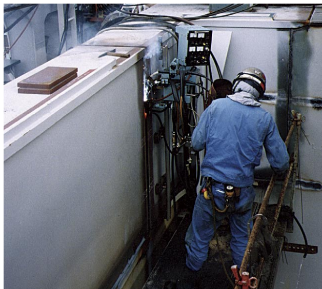
図 11 大型コンテナ船への 2電極VEGA溶接機の適用状況
