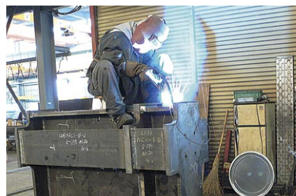
半自動で溶接中のSRCコア部
