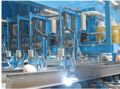
図1 HS-MAG 溶接状況 (造船所パネルライン)
