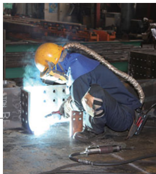
(左)工場内の一隅 (右) 耐候性鋼による橋梁部材の溶接状況。ソリッドワイヤ◎YM-55W(ワイヤ径1.2mm)が採用されている。
