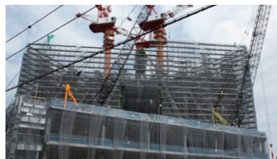
東京スカイツリー建設現場(5月22日撮影)
