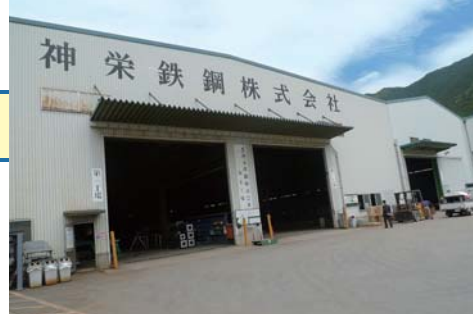
工場外観の一部
