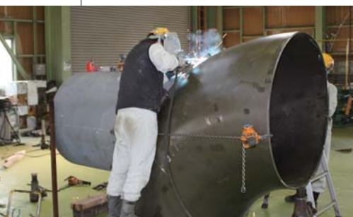
溶接風景(工場屋内)
