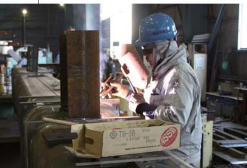
溶接風景(瀬高工場)
