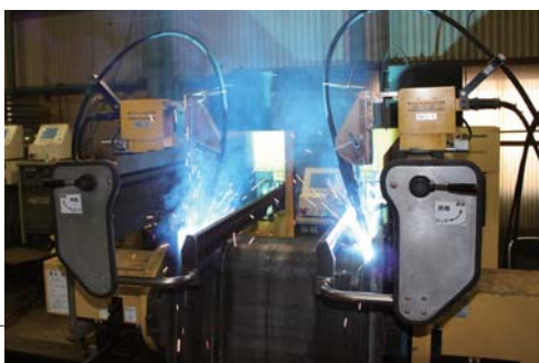
簡易ロボット溶接(本社工場)
