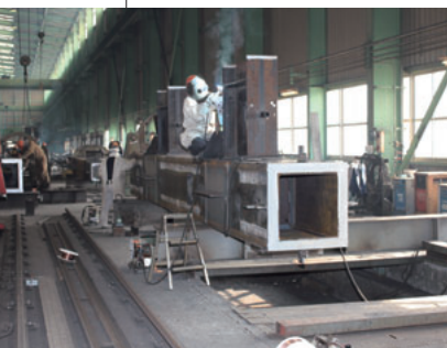
柱大組立溶接
