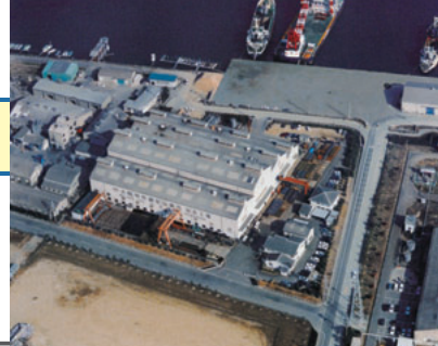
徳島第1工場全景
