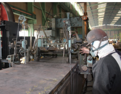
SESNET(エレクトロスラッグ溶接)
