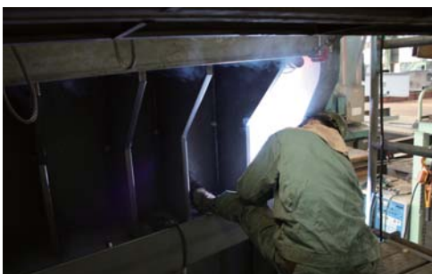
橋梁端部 CO 2 半自動溶接
