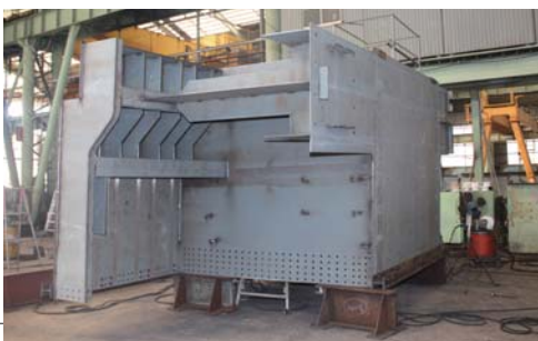
橋梁端部(上の写真の全景)
