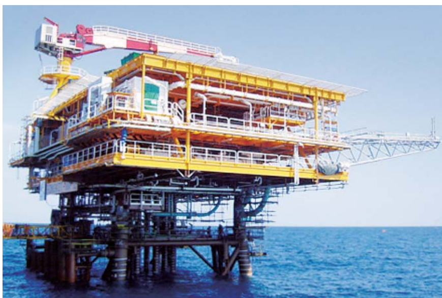
写真1 ジャケット式プラットフォームの例
