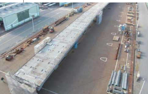
橋梁美坂組立
