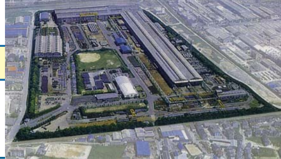
半田工場全景
