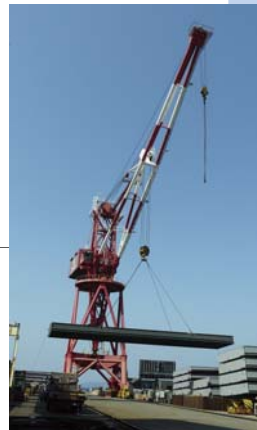
ハッチカバーを吊り 上げる大型クレーン
