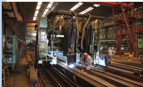
桁自動溶接装置
