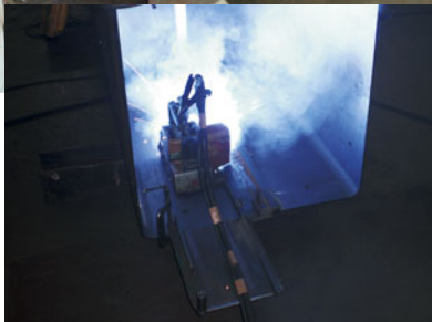
簡易自動車キャリアボーイ・エースによる溶接状況
