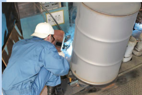
特殊ドラム缶の胴体と底板(地板)の側周折曲げ部を外側から溶接
