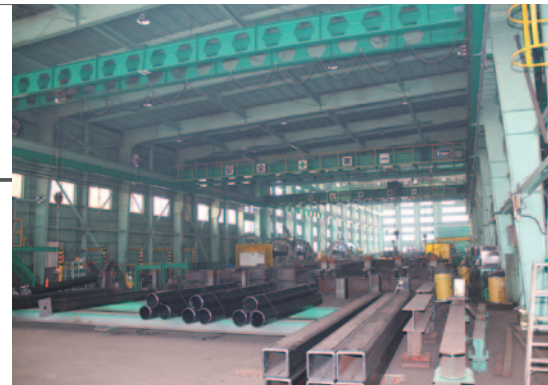
本社工場内観 照明を水銀灯からLEDに付け替え22%の節電効果をあげた
