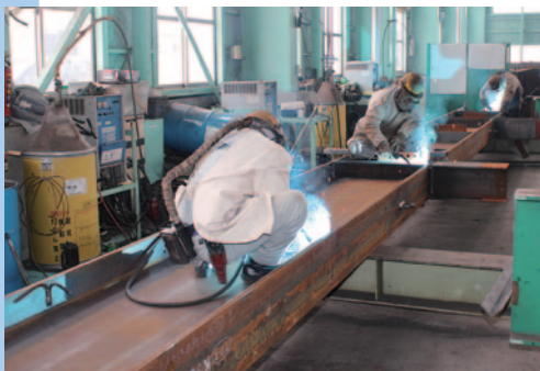
半自動溶接の様子
