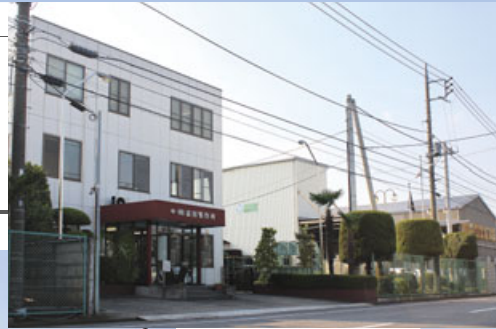
本社・古河工場外観
