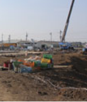
建設中の古河工場 新工場予定地
