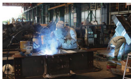
突き合せ溶接(左手前)とガスシールドアーク溶接(右奥)
