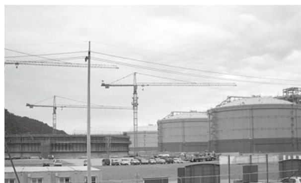
図 3 LNG タンク外觀
