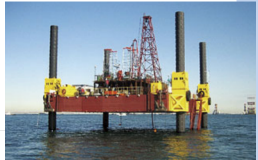
洋上作業台施工例
