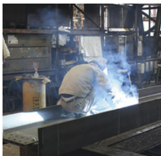
梁ガセット半自動溶接
