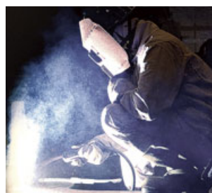
加圧式タンク内容接作業
