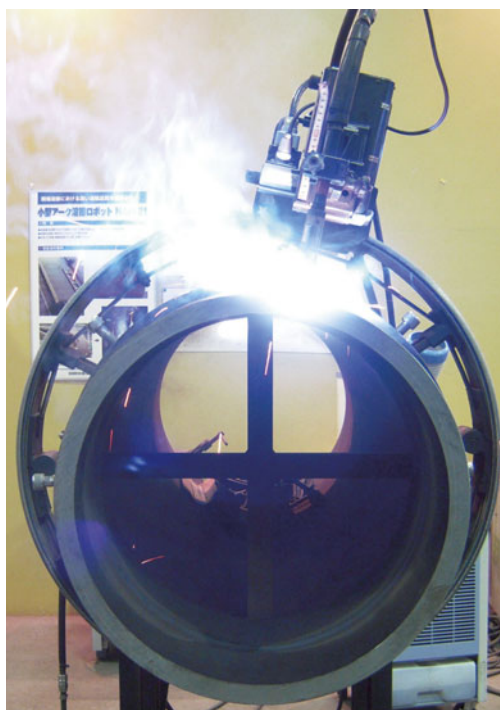
● 6時→12時の上進溶接状況
