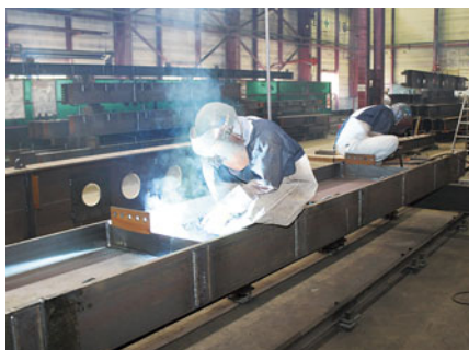
梁半自動溶接
