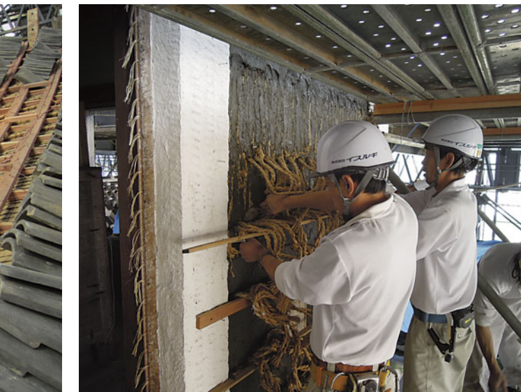
外壁土壁補修中
