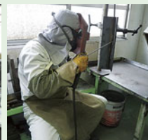
溶接検査風景
