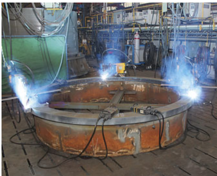
デッキクレーンポスト回転台の自動溶接
