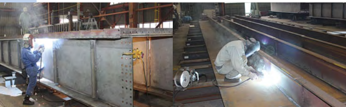
CO 2 半自動溶接
