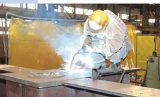
半自動アーク溶接
