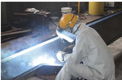
BH 柱材の半自動溶接
