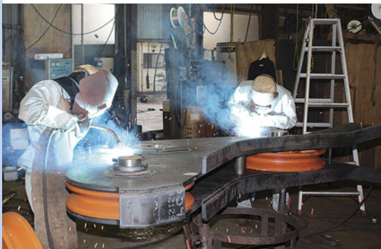
アップブロック部の半自動溶接
