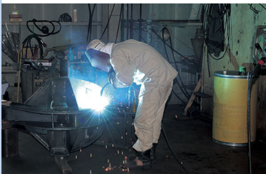
シェル部の半自動溶接
