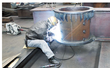
ダム作業機橋構造材すみ肉溶接
