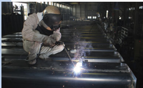
溶接棒による突合せ溶接
