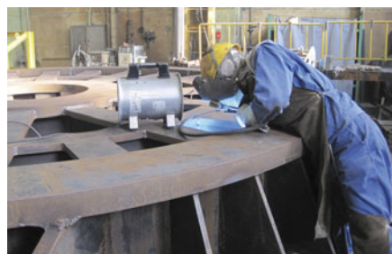
超大型立旋盤ベッド下部すみ肉溶接
