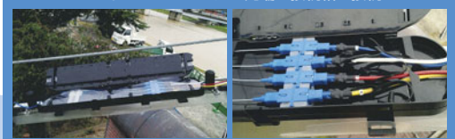
ピコドラマのケーブルの先端を接続箱に接続
