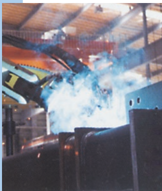
大組ロボット溶接
