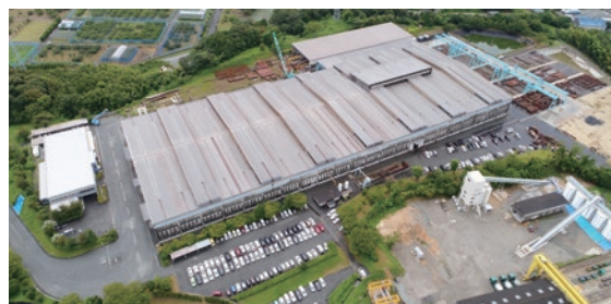
松橋工場外観
