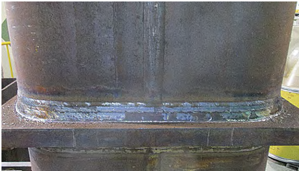
写真 3 SX-55 の溶接外観
