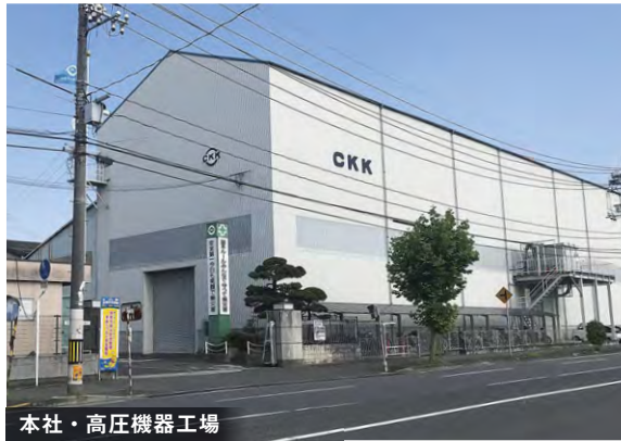
本社・高圧機器工場
