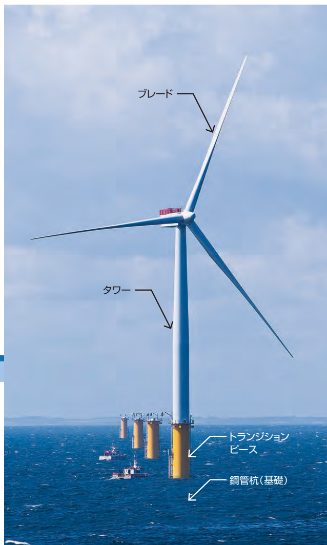
写真1 洋上風力発電(モノパイルタイプ)一例 ブレード・タワー・トランジションピース・鋼管杭(基礎)
