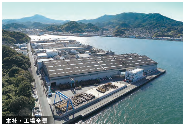
本社・工場全景
