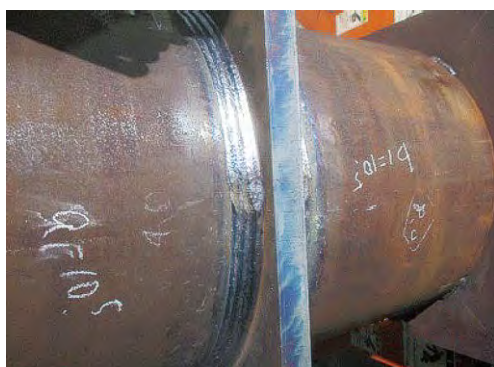
写真8 円形鋼管×SX-26の溶接外観
