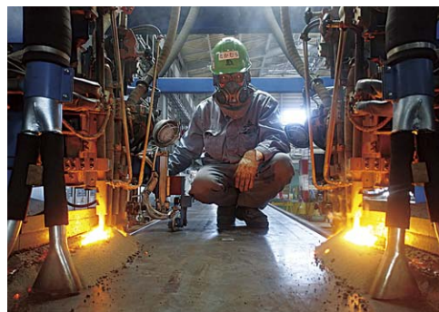
サブマージアーク溶接
