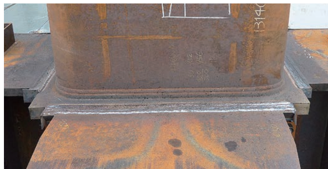
現場溶接の仕上がり
