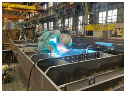
溶接作業の様子
