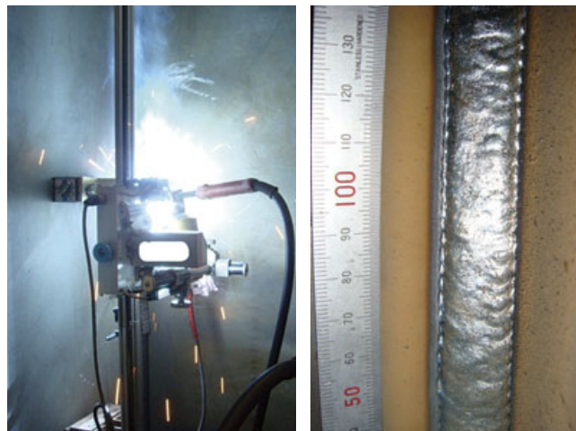
写真1 SY-mini での立向上進施工例と SF-1V のビード外観一例
